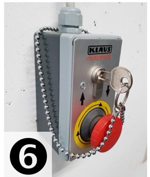
➔ Mit dem Schlüssel kann die Hebebühne betätigt werden
